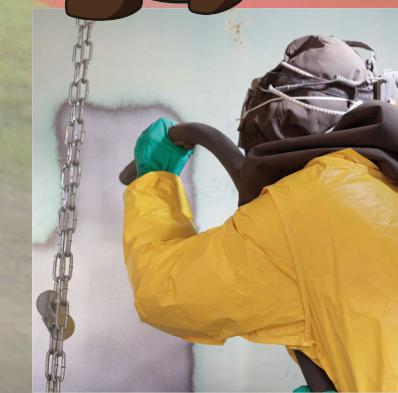
粉じん発生の少ない施工状況
